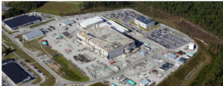
図 8 建設中の米国「MOX 燃料製造施設（MFFF）」（2014 年 10 月 25 日）
